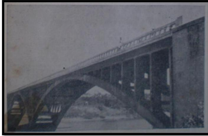
Fotografia 3: Ponte de concreto armado sobre o rio Poty.
