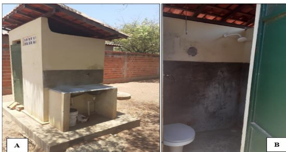
Fotografia 1 – Banheiro construído nas residências de Mirolândia
