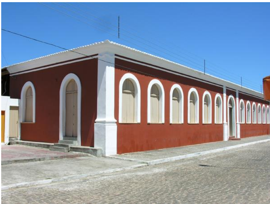
Figura 1- Prédio construído para a sede do Estabelecimento Rural de São Pedro de Alcântara. Fonte: https://www.thecities.com.br/Brasil/Piau%C3%AD/Floriano/ .
