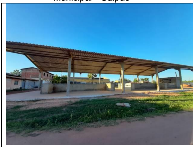
Figura 44 - Estrutura do Mercado Municipal - Galpão
