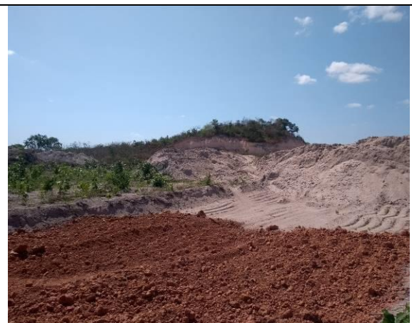
Figura 36 - Usos de recursos minerais na instalação de empreendimento imobiliário
