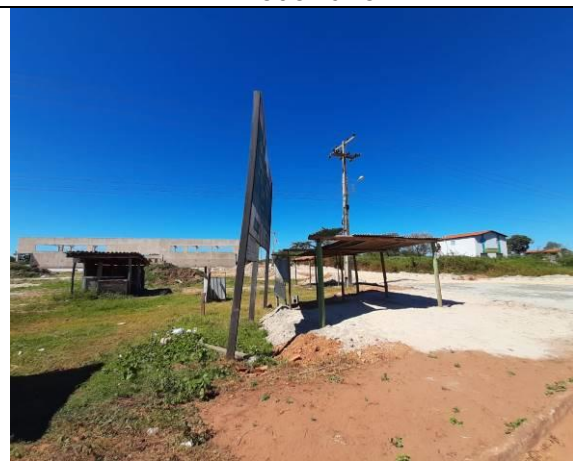
Figura 16 – Instalação de comércio sazonal próximo à instalação do Terminal Rodoviário
