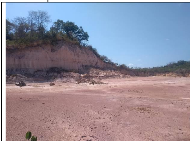
Figura 35 - Extração e uso de recursos minerais em instalação de empreendimento imobiliário
