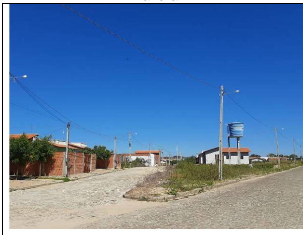
Figura 12 - Infraestrutura - Residencial Primavera
