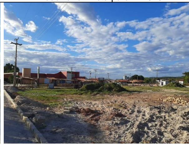
Figura 18 - Instalação do Terminal Rodoviário - vista para BR 343
