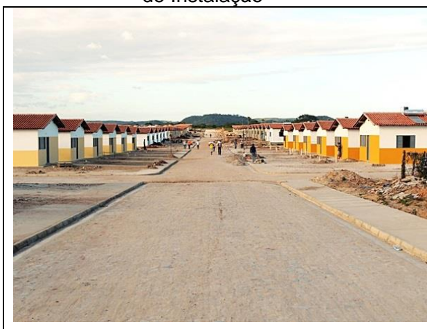
Figura 46 - Residencial Cezar Leal - Fase de Instalação
