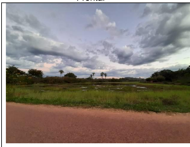
Figura 50 - Açude da Tranqueira - Vista Frontal
