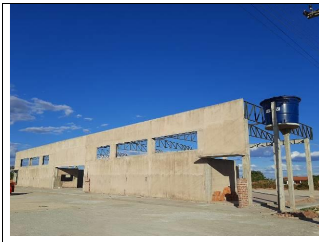
Figura 15 - Instalação de Terminal Rodoviário
