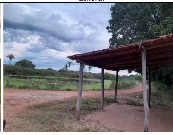
Figura 51 - Açude da Tranqueira - Vista Lateral
