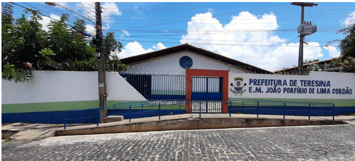
Figura 9. Fachada da Escola Municipal João Porfírio de Lima Cordão, Teresina, Piauí.
