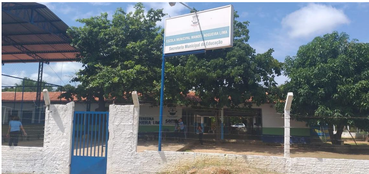
Figura 13. Fachada da Escola Municipal Manoel Nogueira Lima, Teresina, Piauí.
