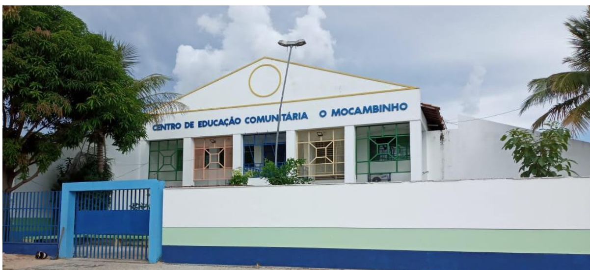
Figura 10. Fachada da Escola Municipal Mocambinho, Teresina, Piauí.
