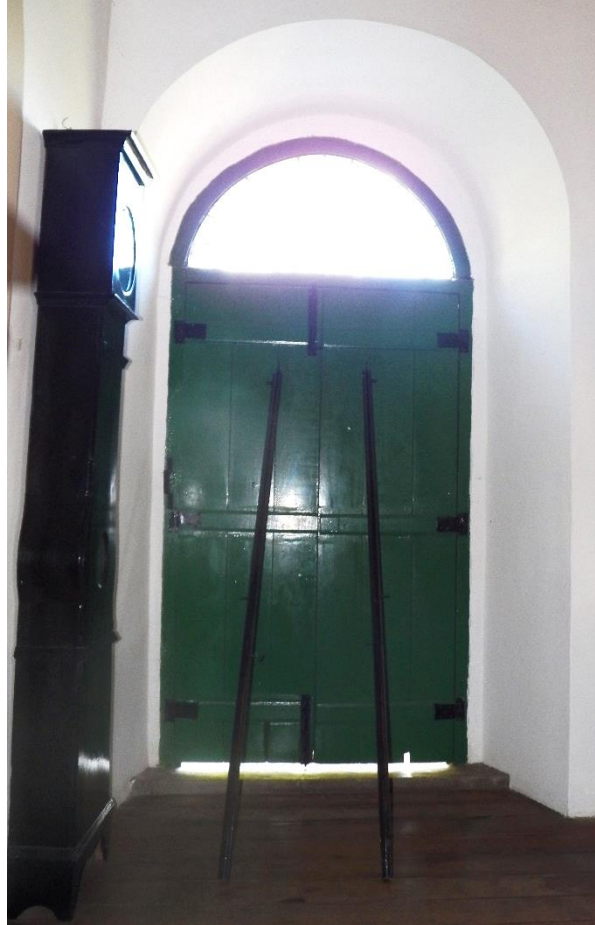
FIGURA 17: PORTA COM REFORÇO NA FECHADURA.
