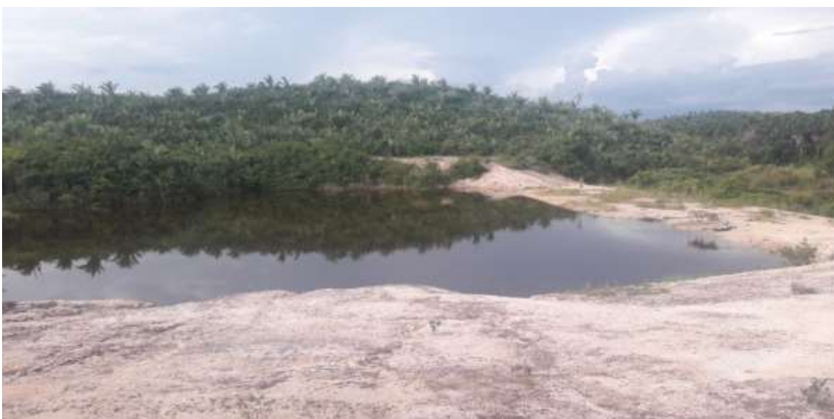
Fotografia 9: Barragem inacabada da Comunidade Piqui da Rampa.
