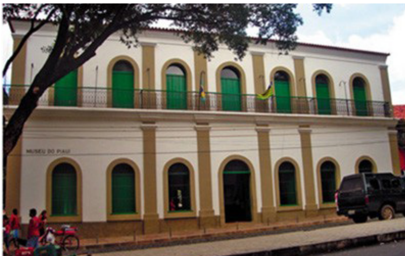
Fachada do edifício do Museu do Piauí. Fonte: FUNDAC
