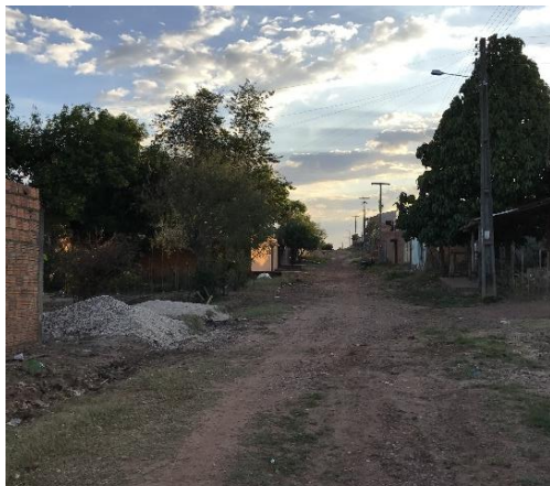
Figura 10.17: Rua sem calçamento na Vila Santa Bárbara
