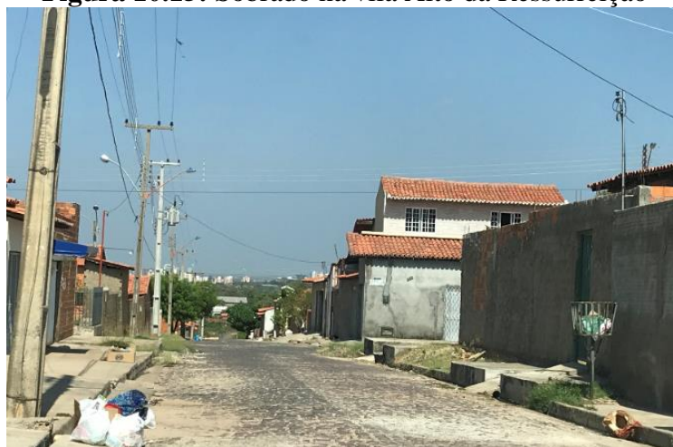
Figura 10.15: Sobrado na vila Alto da Ressurreição
