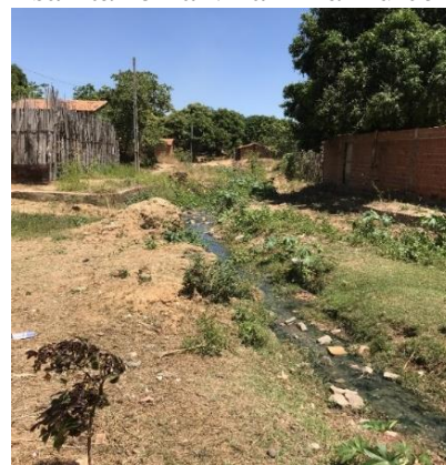
Figura 8.3: Ausência de esgotamento sanitário na Vila Irmã Dulce
