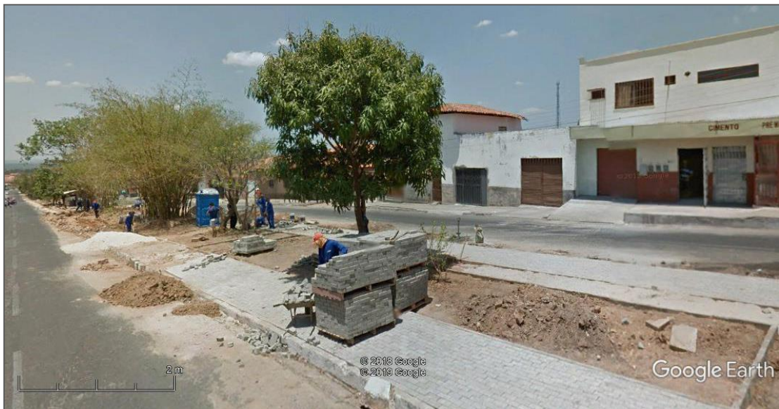
Figura 18 – Fotografia de início da reestruturação das galerias na Avenida Deputado Ulisses Guimarães, no Conjunto Promorar, 2012
