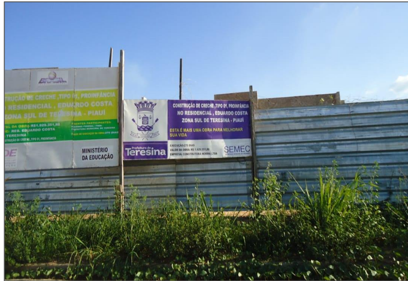
Figura 23 – Fotografia de uma escola para a educação infantil em construção no Residencial Orgulho do Piauí
