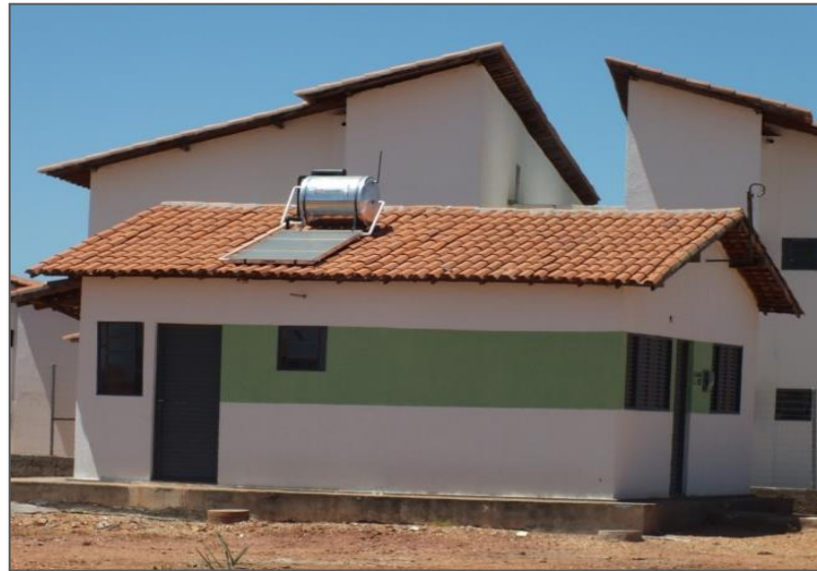
Figura 11 – Fotografia de aquecedor de água solar no Residencial Portal da Alegria VI-A
