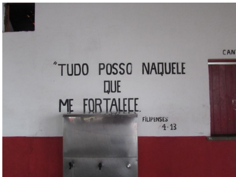
Figura 4: detalhe das paredes, Fl 4:13.
