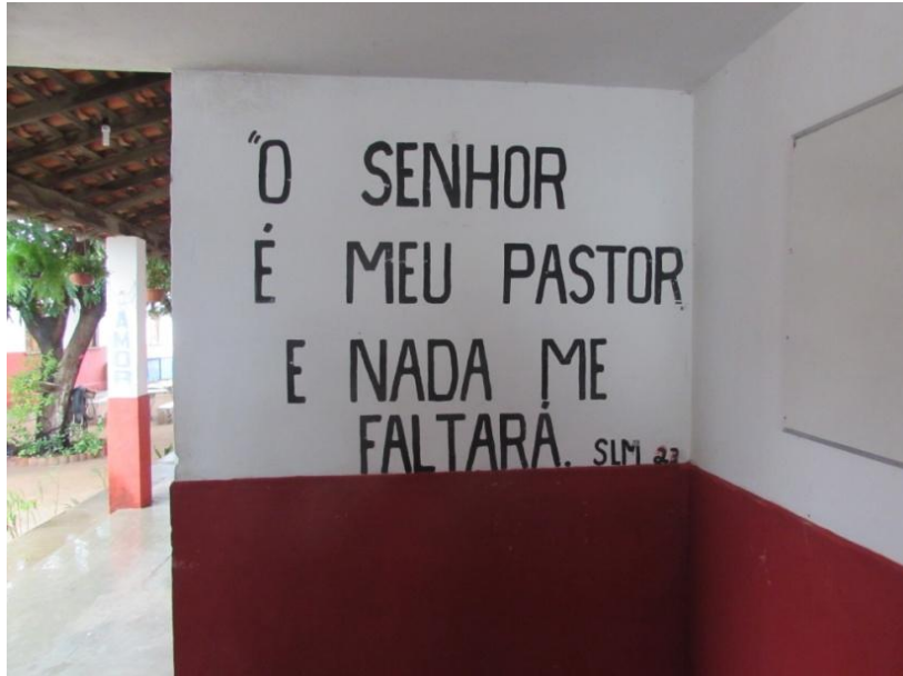
Figura 2: detalhe das paredes, Sl 23: 1.
