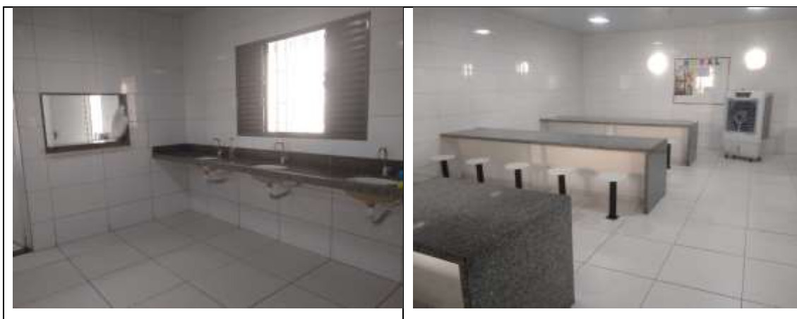
Figura 26 - Fotografias do refeitório
