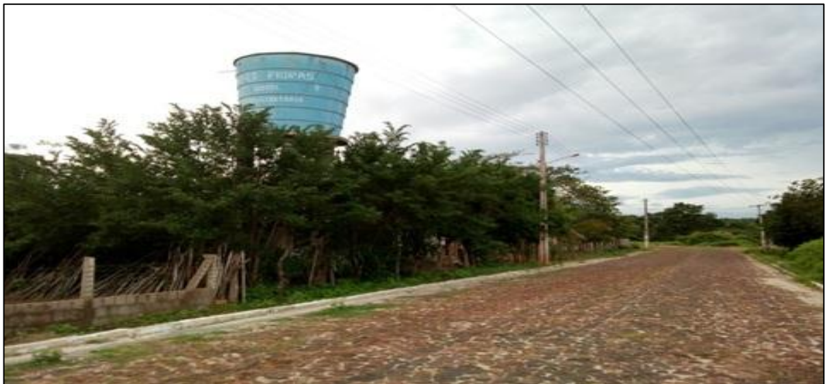
Figura 13 – Abastecimento de água e energia elétrica, Assentamento Cansação, município de Cocal, Piauí.
