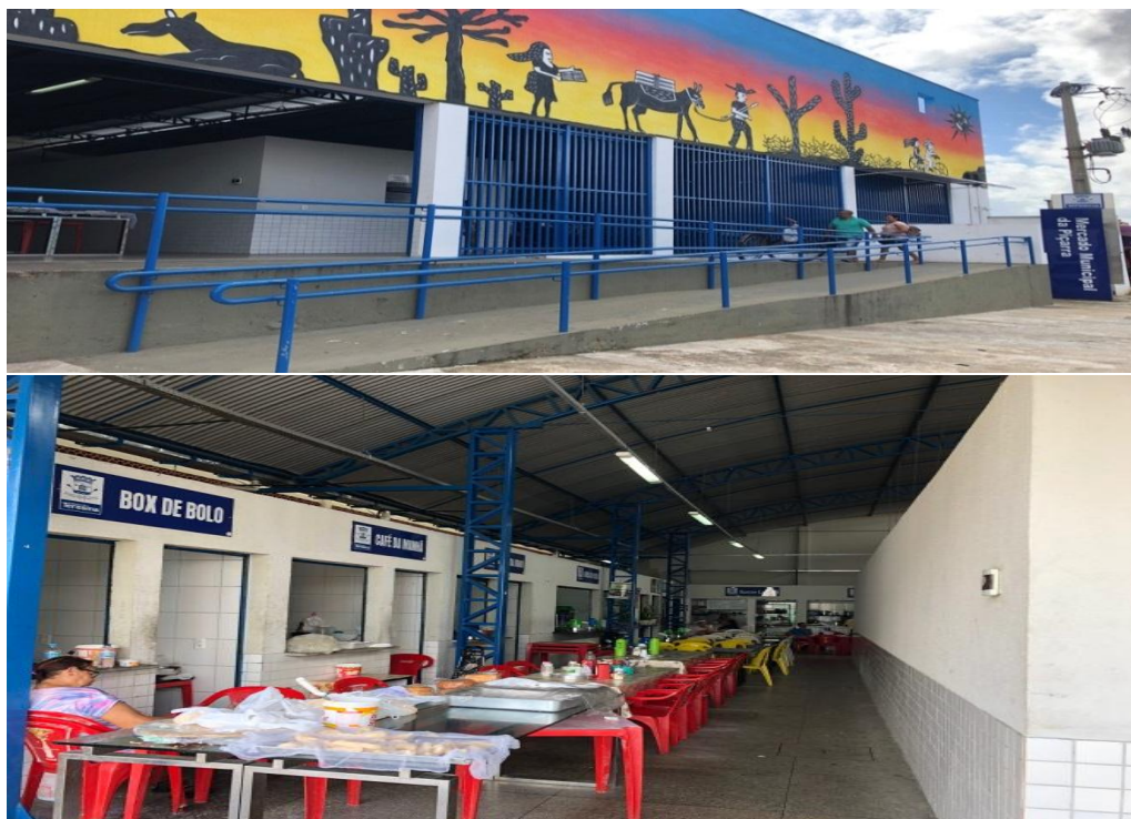
Figura 6. Setor de Refeição do Mercado da Piçarra após Reforma. Teresina-PI, 2018.
