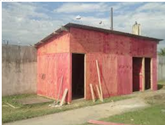
Figura 11 – Construção provisória executada em canteiros de obras tipo “barracão”
