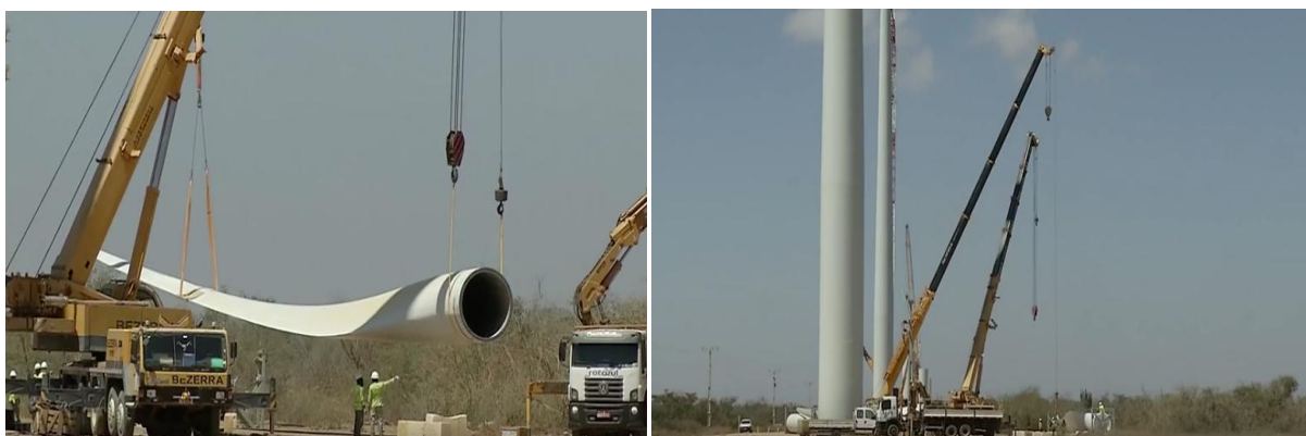
Figura 43 - Empresas especializadas atuando na montagem dos aerogeradores em Marcolândia.
