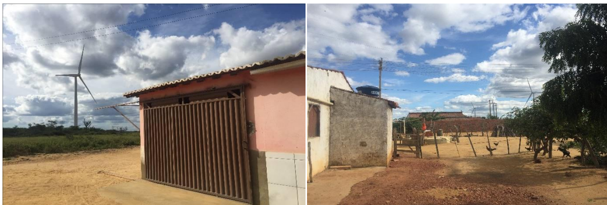
Figura 42 - Aerogeradores próximo as residências rurais em Marcolândia
