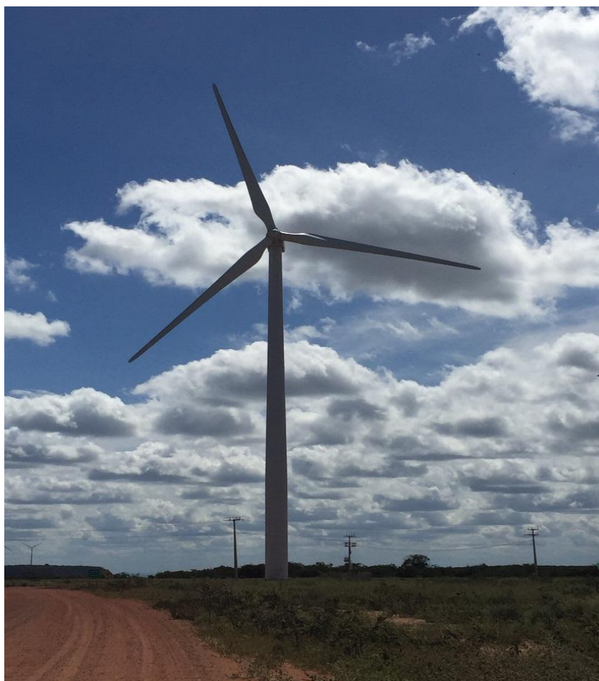
Figura 37 - Aerogerador instalado no Complexo Eólico Chapada do Piauí
