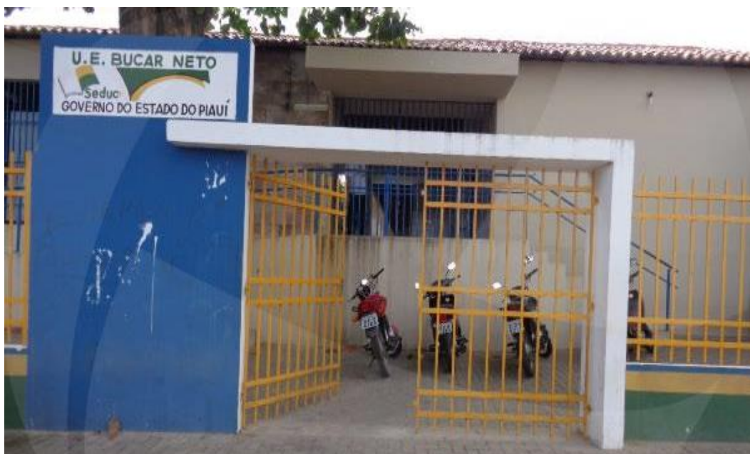
Figura 5 - Fachada da Unidade Escolar Bucar Neto
