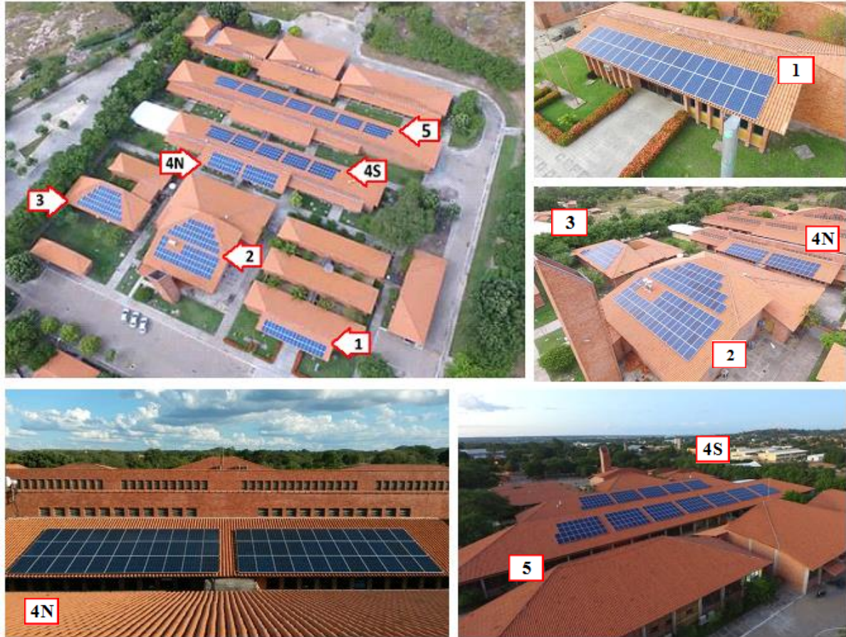
Figura 17 – Disposição dos módulos fotovoltaicos sobre o telhado do campus e detalhe de cada arranjo.
