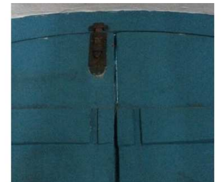
FIGURA 56- Esquadria com fechadura arrancada. Fonte: Arquivo Arquiteta Ellaine Martins, 2017.
