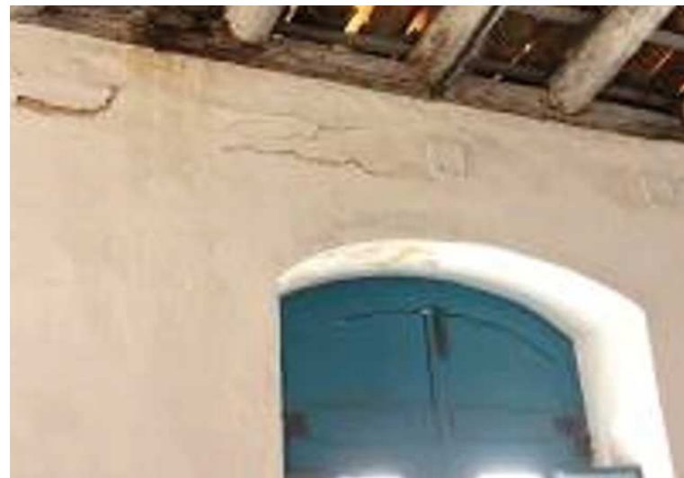
FIGURA 52 – Desgaste do acabamento da parede. Fonte: Arquivo Arquiteta Ellaine Martins, 2017.
