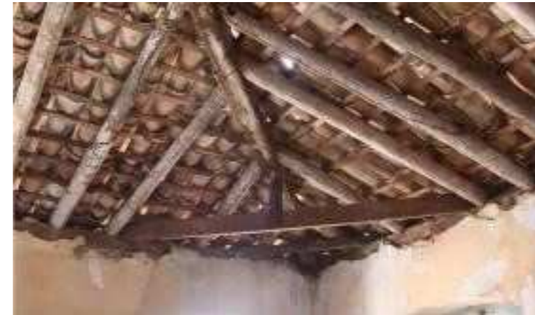
FIGURA 21 - Vista da estrutura da Cobertura. Fonte: IPHAN, 2009.
