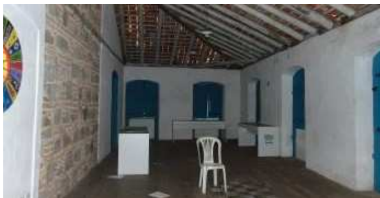
FIGURA 35 – Sala do Terceiro Pavimento, sem uso. Fonte: Arquivo Arquiteta Ellaine Martins, 2016.
