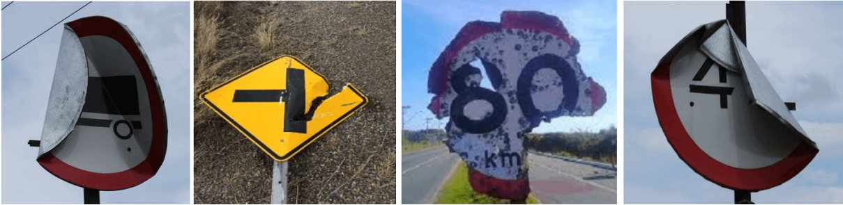
(a) Exemplos de placas de trânsito danificadas por fatores físicos.
