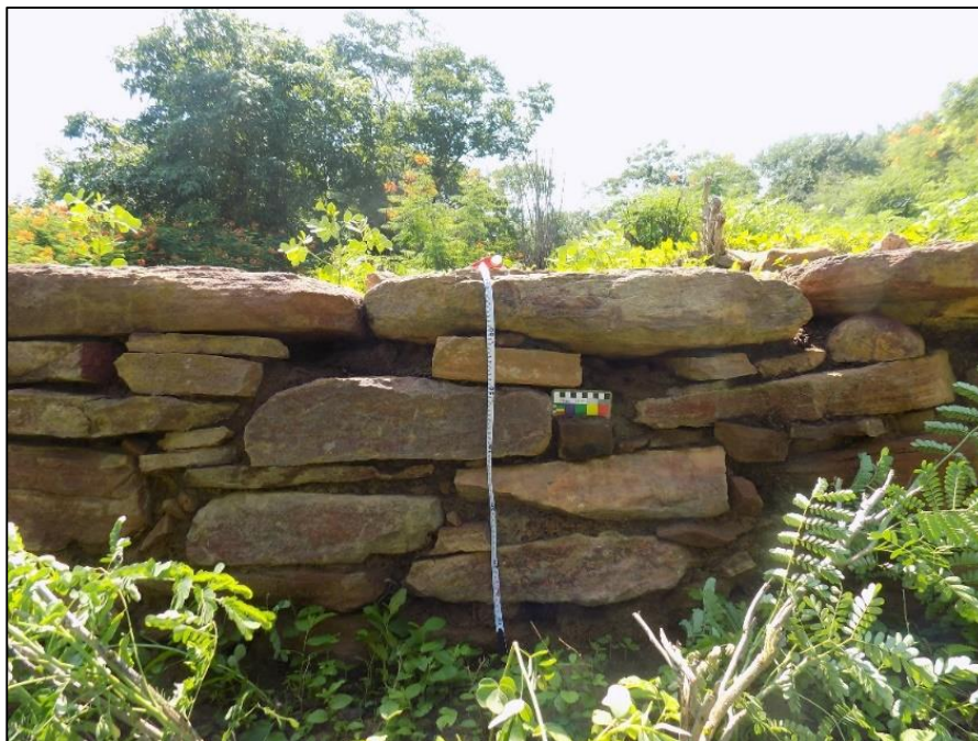
Figura 6: Estrutura de pedra encaixada. Fonte: Ana Oliveira, 2016.
