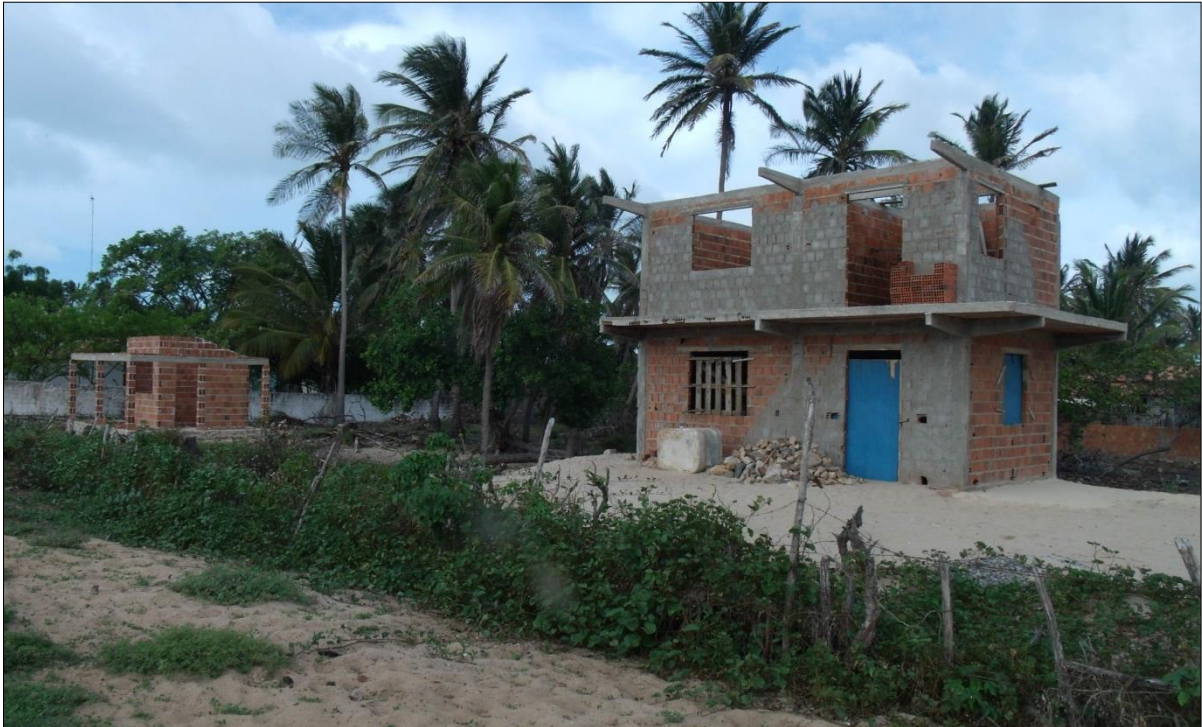
Figura 7: Construções de casas na Pedra do Sal
