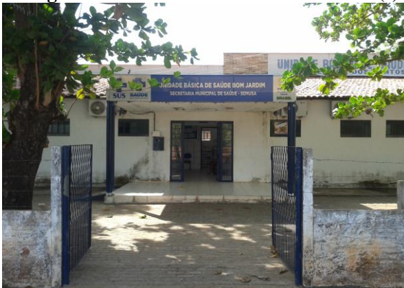
Imagem 10: Fachada de entrada da UBS3 (I)
