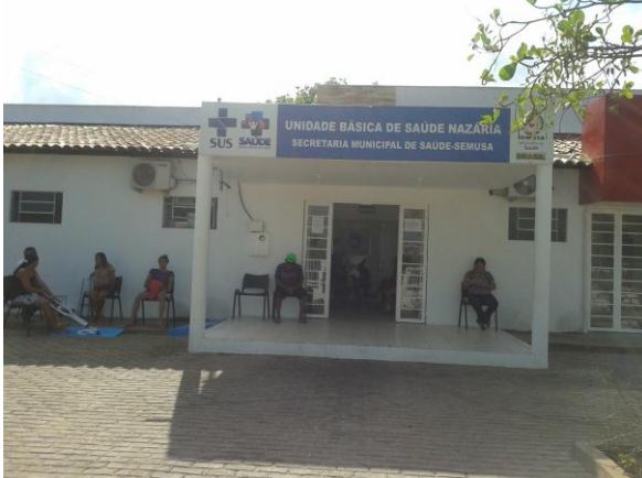
Imagem 02: Fachada de entrada da UBS1 (I)
