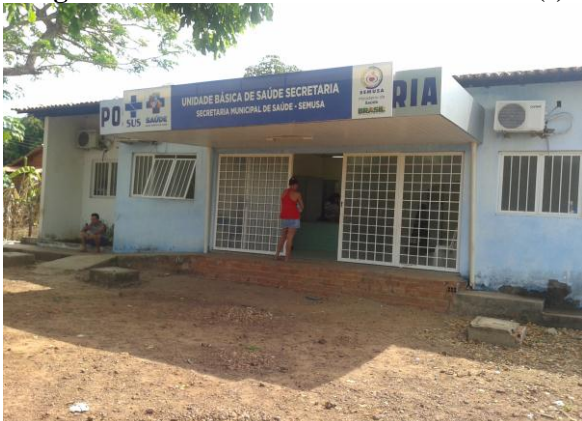
Imagem 06: Fachada de entrada da UBS2 (I)
