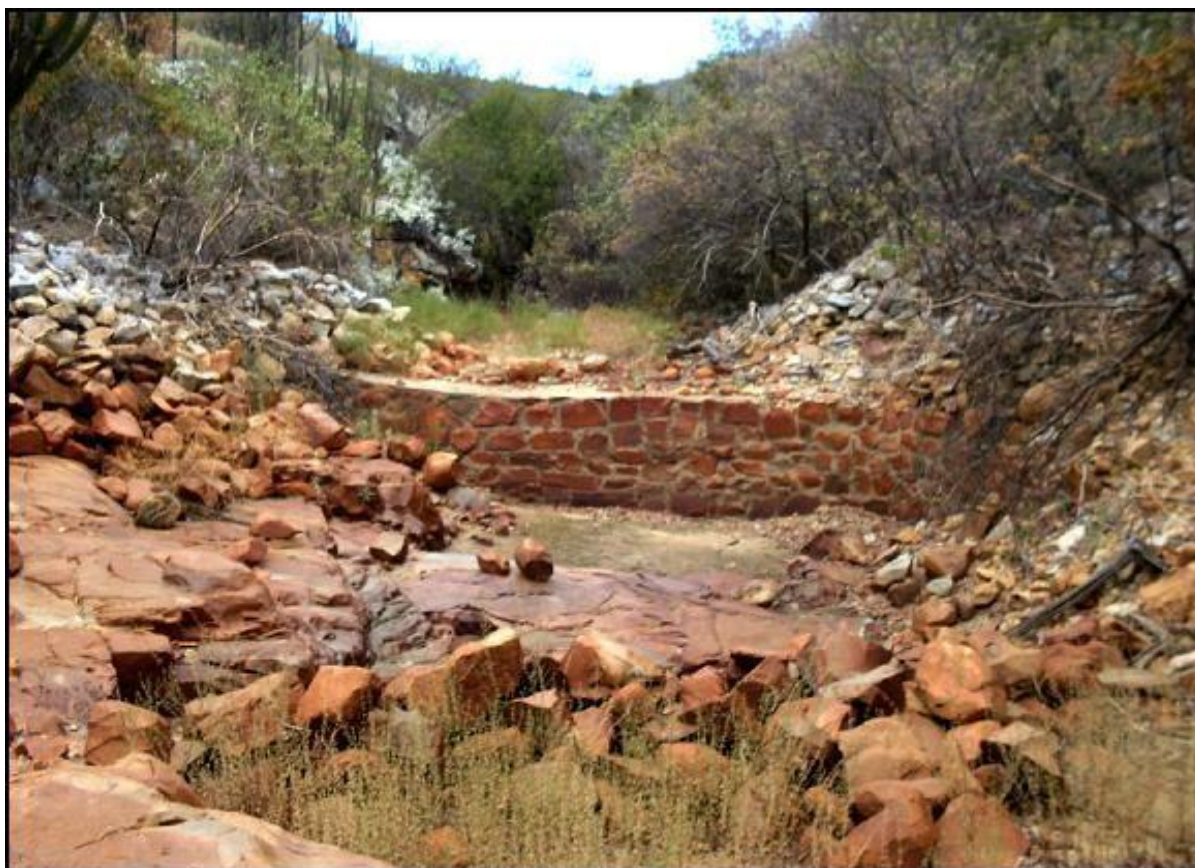
Estrutura construída para armazenar água pluvial para apoio ao garimpo
