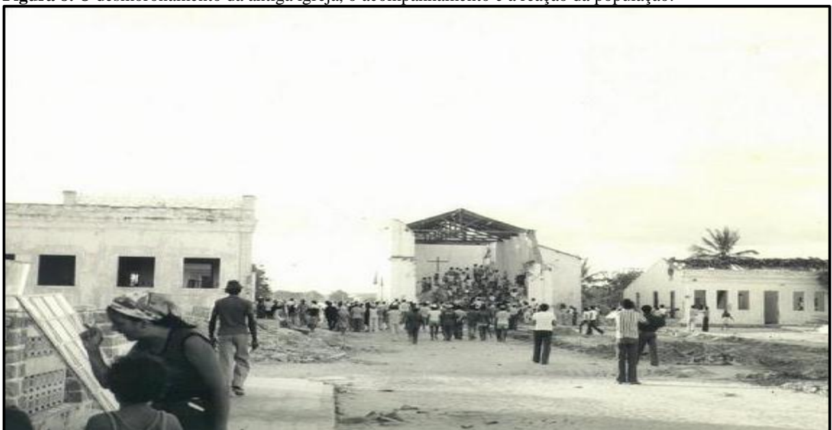
Figura 8. O desmoronamento da antiga igreja, o acompanhamento e a reação da população.
