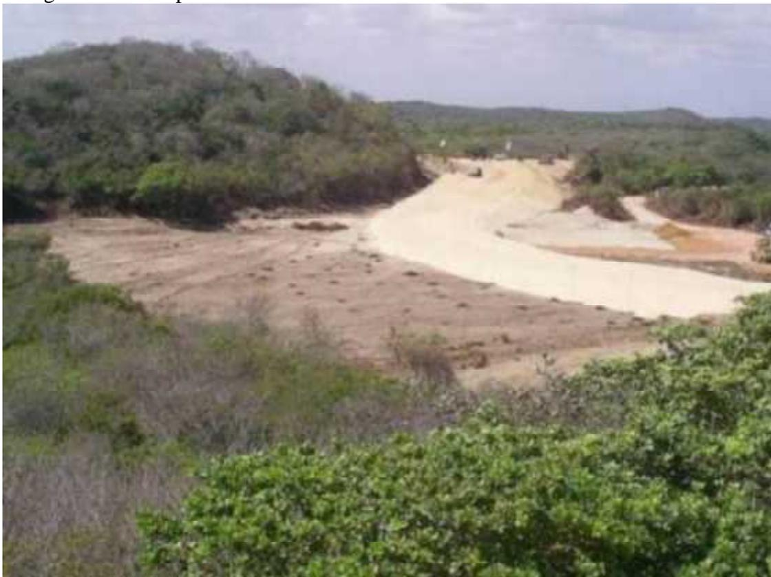
Base da duna fixa retira, com a remoção do solo para a instalação de vias de acesso de canteiro de obras (campo de dunas da Taíba)
