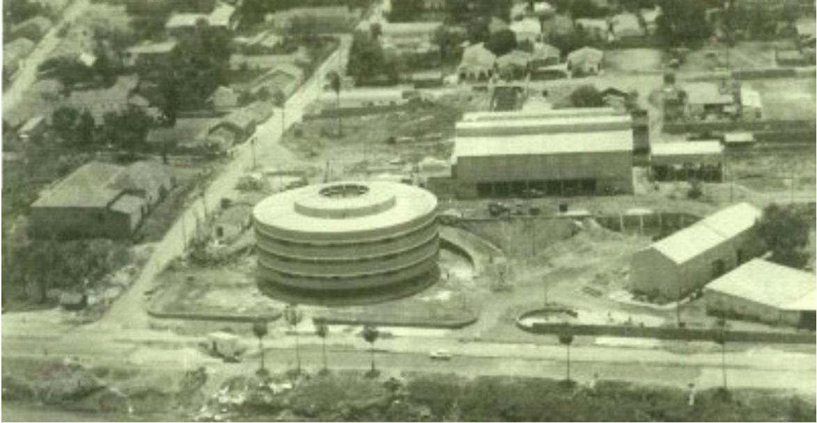
Figura: 21: Sede da CEPISA. Fonte: Teresina entre 1973 e 1974 . Disponível em: < http://teresinaantiga.com/teresina-1973-1972.php >. Acesso em: 30 de maio de 2018.
