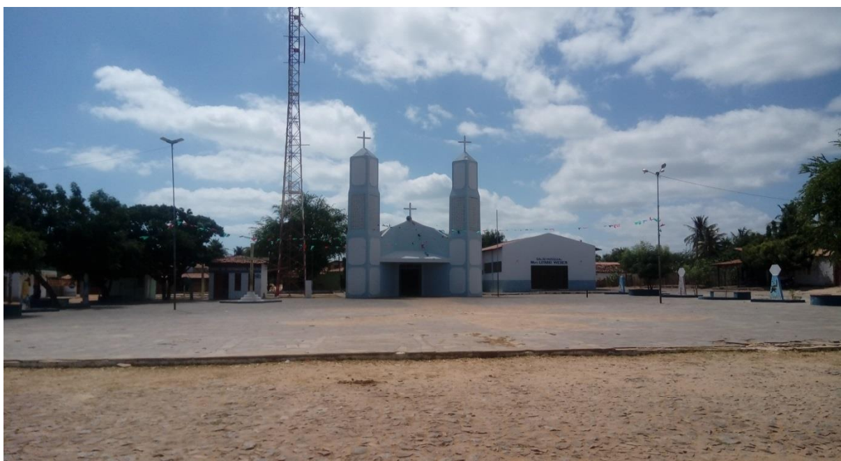
Imagem fotográfica 03: Vista frontal da Praça da Igreja, que mostra a igreja e o salão no lado direito da imagem, tendo do lado esquerdo a torre de transmissão dos sinais de televisão e o posto de informações turísticas ao seu lado. José Maria Alves da Cunha, agosto de 2017.
