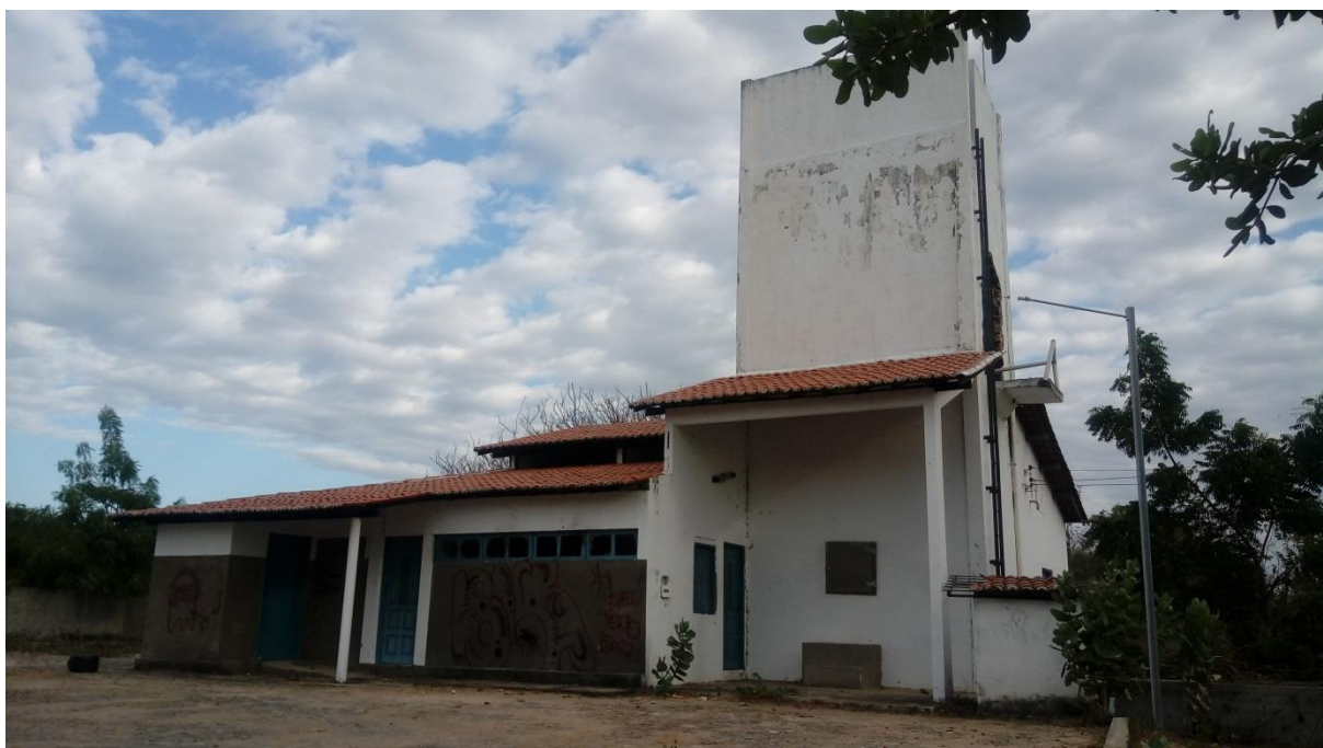
Imagem fotográfica 31: Instalações prediais da antiga fábrica de gelo da localidade. José Maria Alves da Cunha, setembro de 2017.
