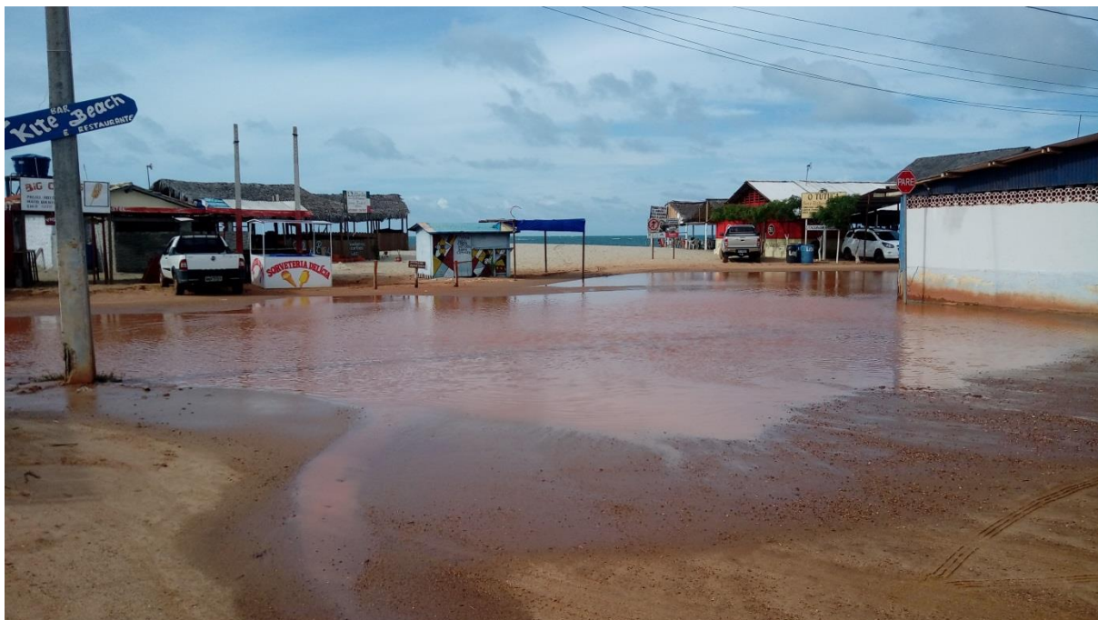
Imagem fotográfica 40: Quando chove a água fica empossada no local onde foi colocada a piçarra compactada (areia pisada). José Maria Alves da Cunha, janeiro de 2018.
