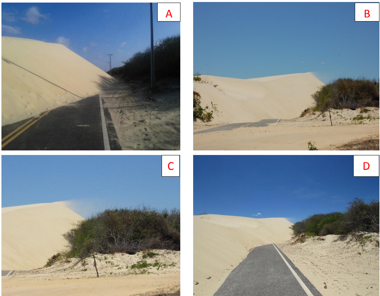
Figura 7 - Dunas móveis avançando sobre a rodovia inviabilizando o acesso à lagoa do Portinho
