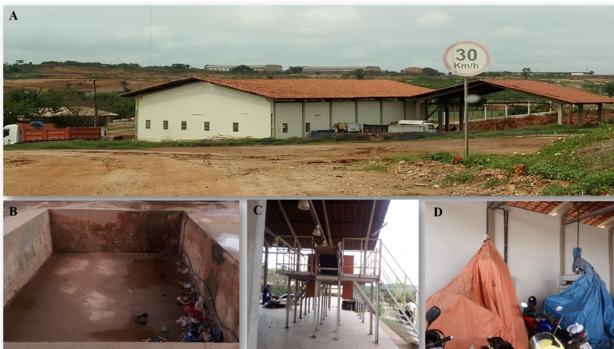
Figura 11 - Local onde funcionaria o galpão de triagem
