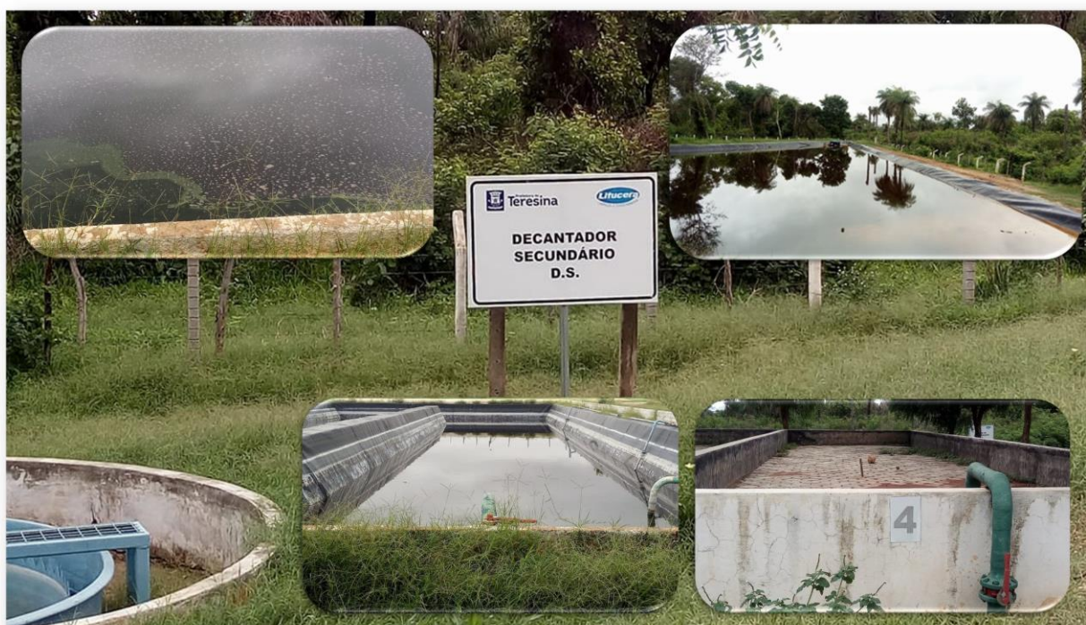
Figura 14 - Obras realizadas para implementação do aterro sanitário
