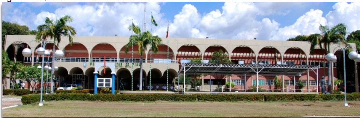
Figura 4: Quartel do Comando Geral - Fachada frontal
