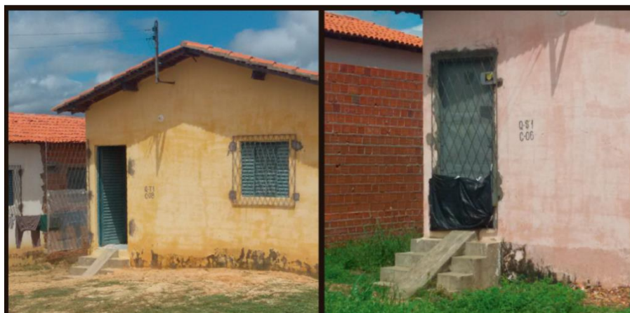
Figura 5-12 - Rampas construídas para facilitar a guarda de motocicleta
