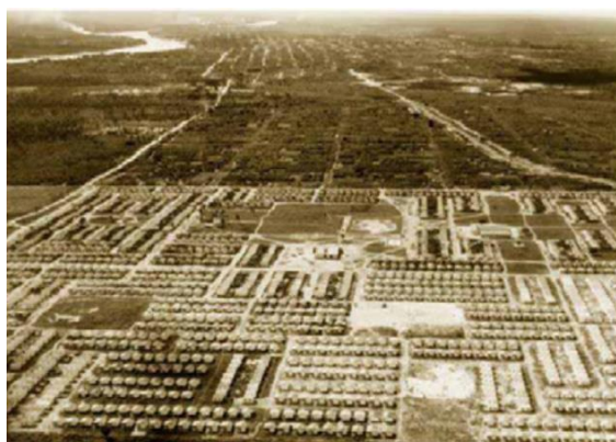
Figura 4-2 - Conjunto Parque Piauí, marcado por vazios urbanos em suas imediações
