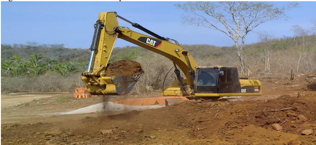
Figura 4 – Retirada da camada superficial do solo
