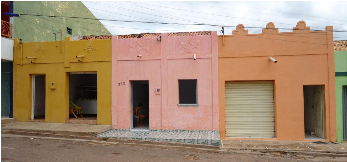
Foto 8: Fachadas de algumas casas antigas, pertencentes às primeiras quadras construídas pelos antigos moradores de Alagoinha, nelas ainda podem ser vistos os detalhes arquitetônicos usados como símbolo, na bandeira do município. Fonte: acervo pessoal de Maria Lucimar da Rocha. 2017.
