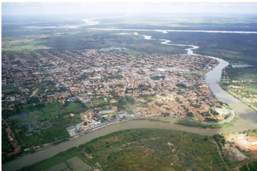
Figura 40 – Construção de residências na cidade de Parnaíba-PI, nas proximidades do rio Igaráçu
