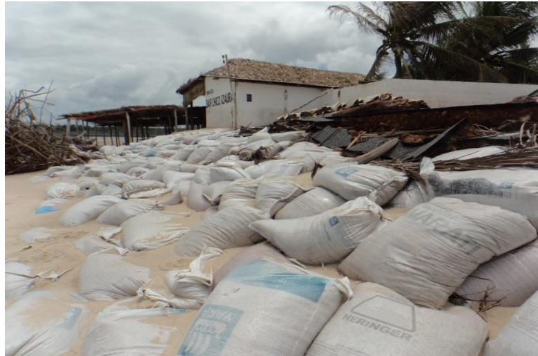
Figura 2 – Barramento para conter o avanço do mar na praia de Macapá, localizada no município de Luís Correia-PI.
