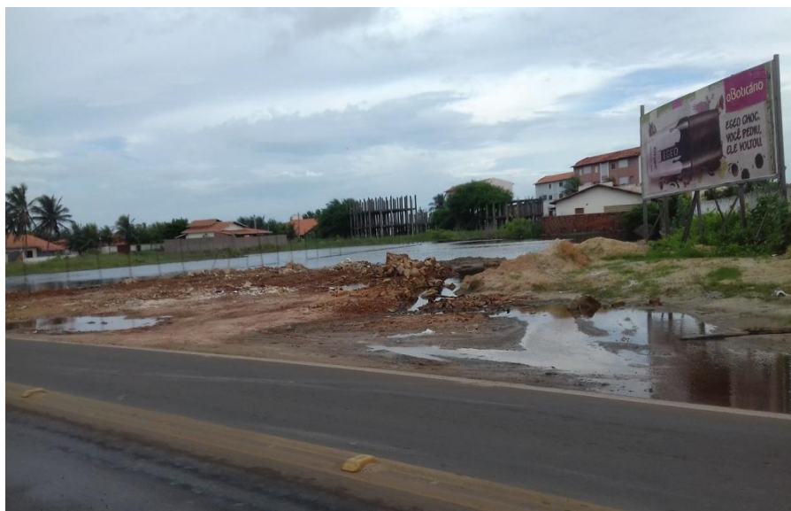
Figura 28 – Área com risco de inundação próximo à praia de Atalaia na cidade de Luís Correia-PI
