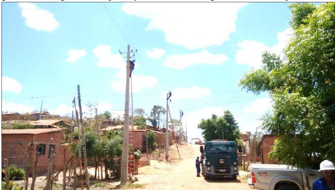
Figura 30 – Fotografia da implantação da rede de energia elétrica no Parque da Vitória.
