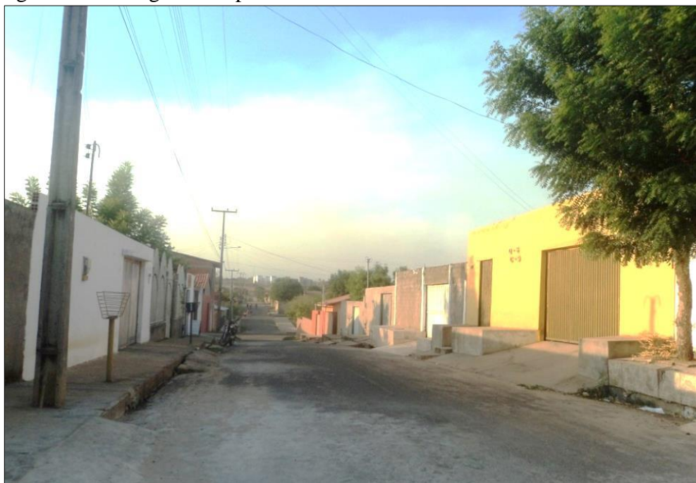
Figura 27 – Fotografia do padrão das casas no Residencial Mário Covas.
