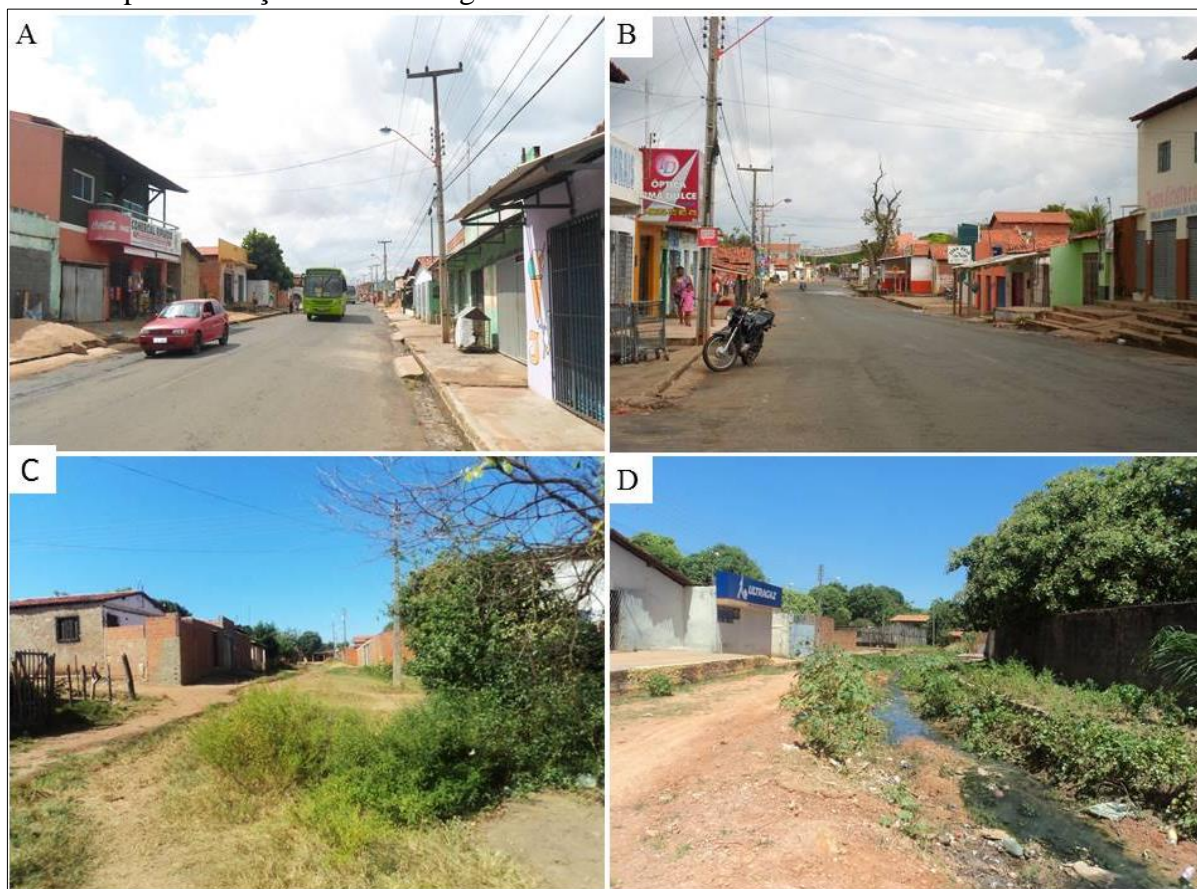
A: Pavimentação asfáltica de vias públicas; B: Padrão de casas nas principais ruas; C: Rua sem nenhum tipo de calçamento; D: Ruas sem rede de esgotos.
