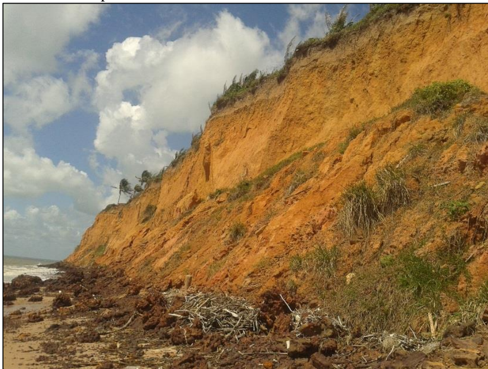
Figura 64 – Fotografia mostrando escorregamento rotacional na falésia de Itapari
