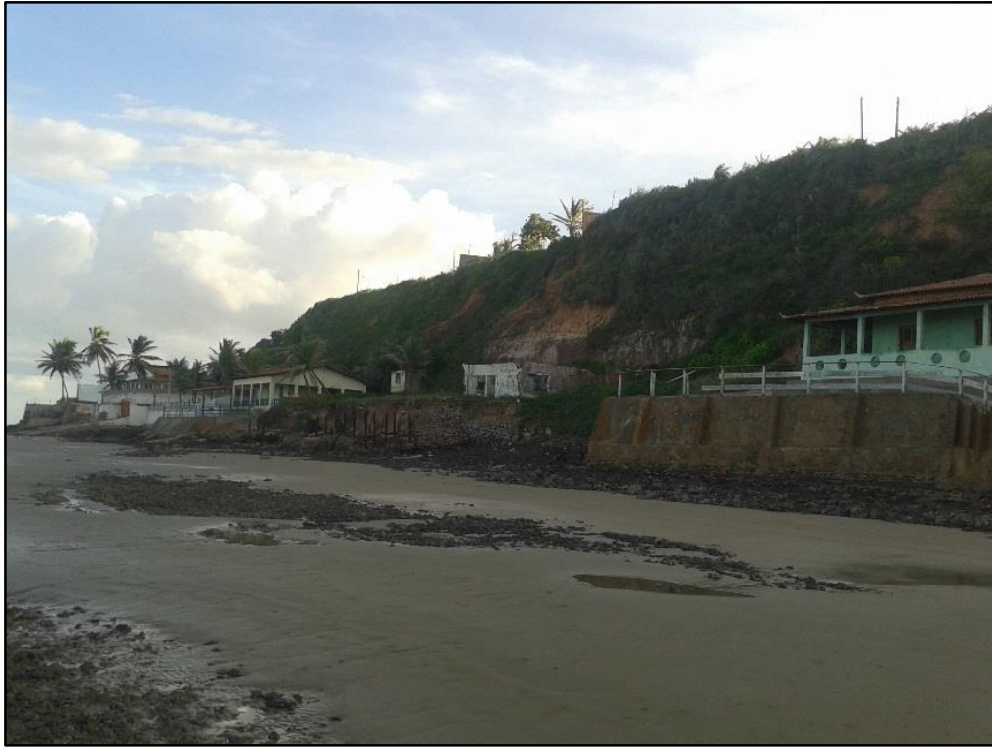
Figura 48 – Fotografia da linha de costa, muros de residências
