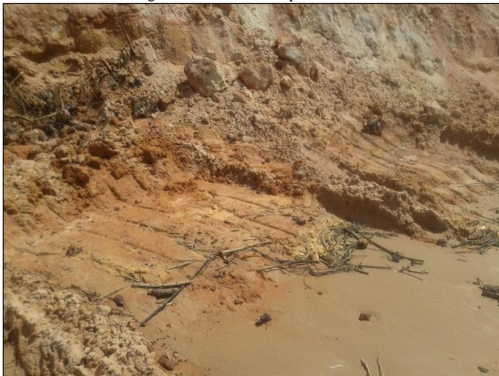
Figura 67 – Fotografia mostrando marcas da escavadeira de trator que retiraram material argiloso da falésia de Itapari
