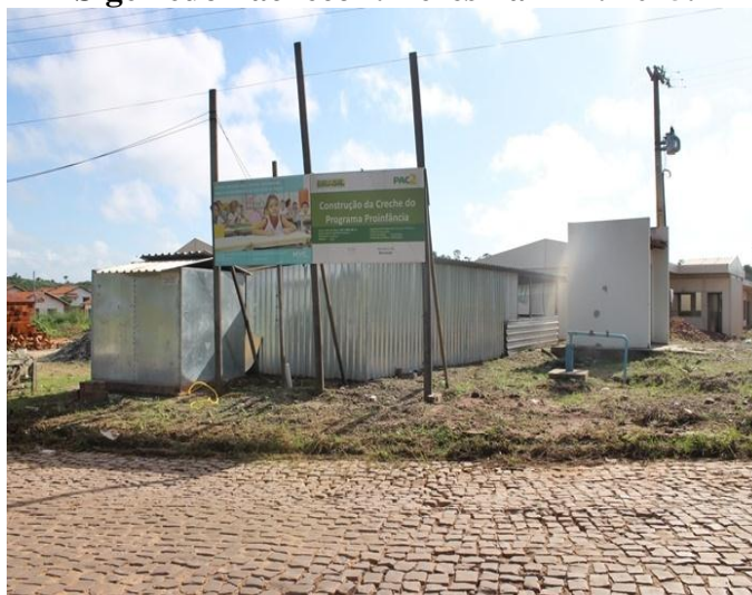
Figura 4 – Obras de creche paralisada no Residencial Sigefredo Pacheco I. Teresina – PI. 2015.
