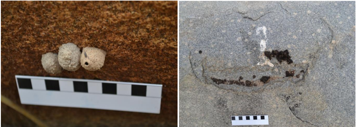
Fig. 51 e 52: Nichos de insetos e excrementos sobre os suportes rochosos e sobre as gravuras
