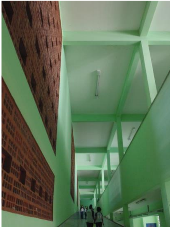
Figura 42: VIGAS APARENTES NO TETO
