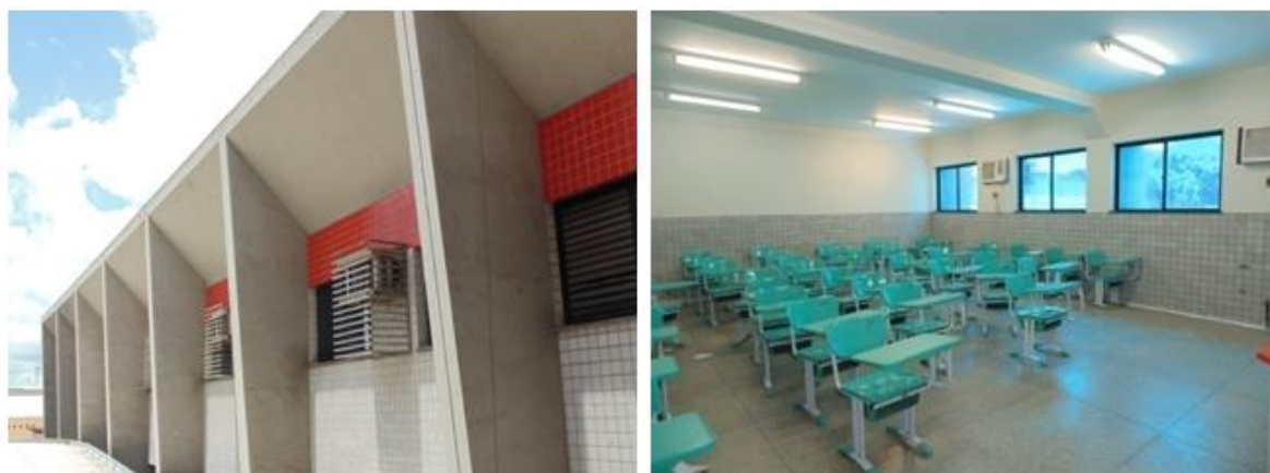
Figura 117: ESTRUTURA EM CONCRETO
