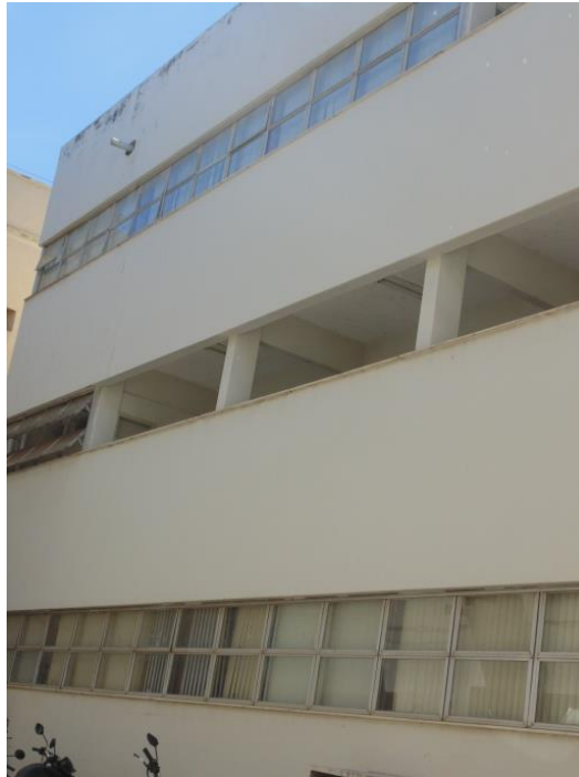
Figura 103: ESQUADRIAS E PILARES
