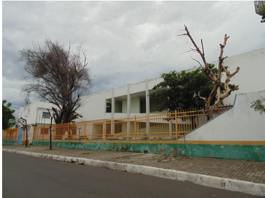
Figura 80: VISTA DA FACHADA
