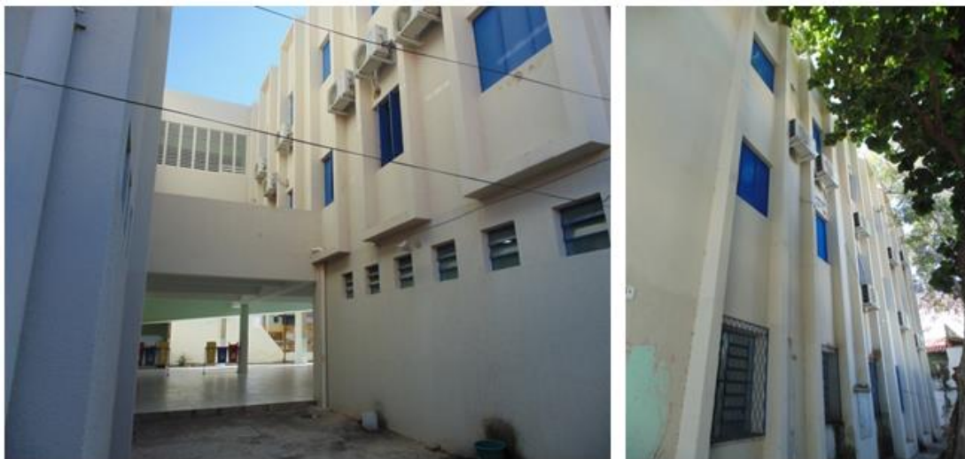
Figura 43: BRISES NAS JANELAS
