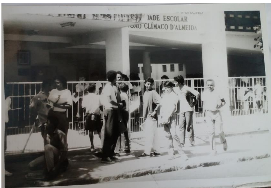
Figura 34: VISTA DA FACHADA COM GRADIL
