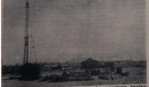
Visão do que se vai fazendo no setor de assistência. Implantação dos novos habitantes do Poly Velho. Uma vista da nova área populacional, com aberturas de poços e construções de residências.
