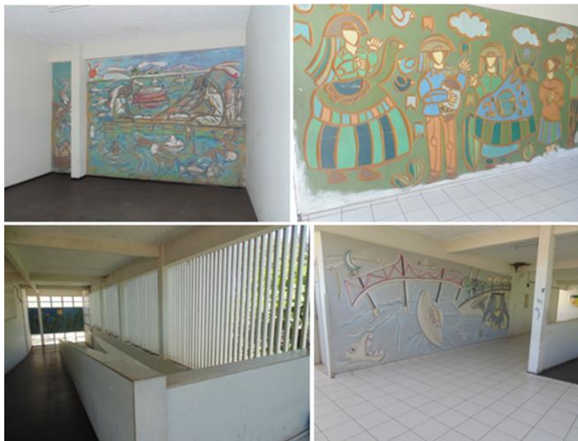
Figura 104: PINTURAS EM CIRCULAÇÕES
