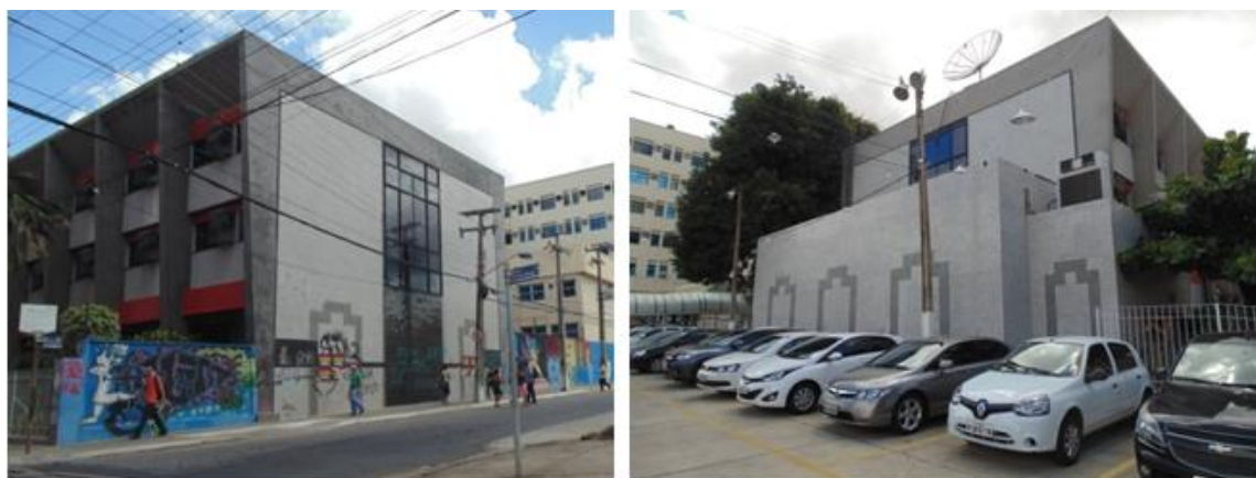
Figura 125: JANELA ENTRE PAVIMENTOS
