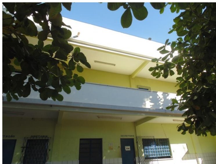
Figura 70: VIGAS EM LAJE
