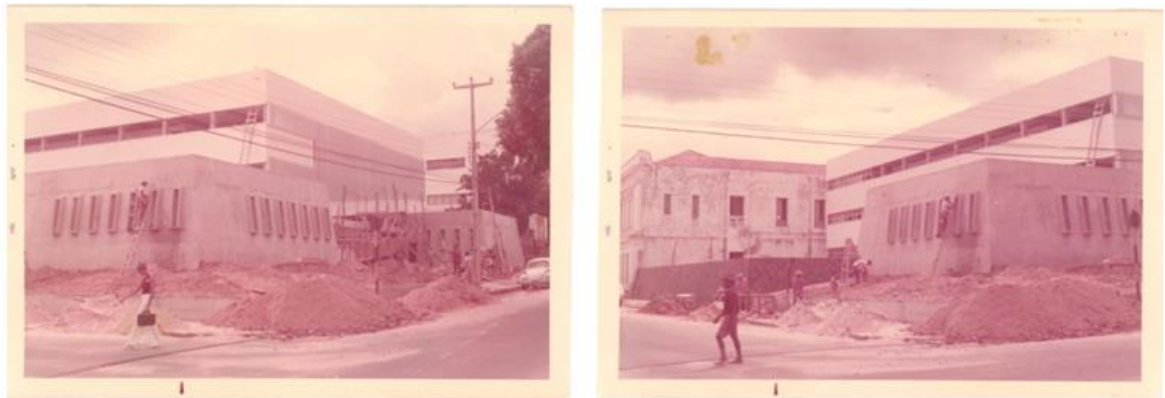
Figura 85: CONSTRUÇÃO DA ESCOLA, 1973
