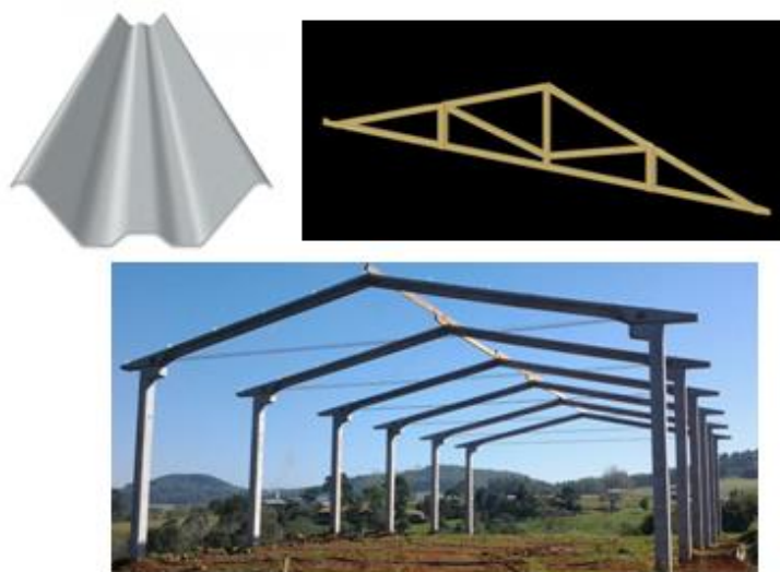
Figura 26: TELHA CANALETE; TESOURA DE MADEIRA; PÓRTICOS DE CONCRETO
