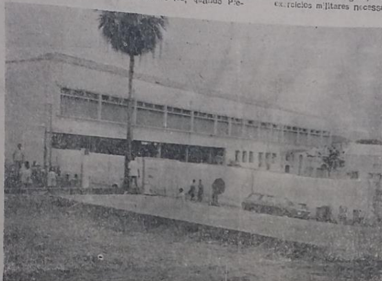
Fachada do Prédio onde funciona a Administração da Escola Técnica Federal do Piauí.
