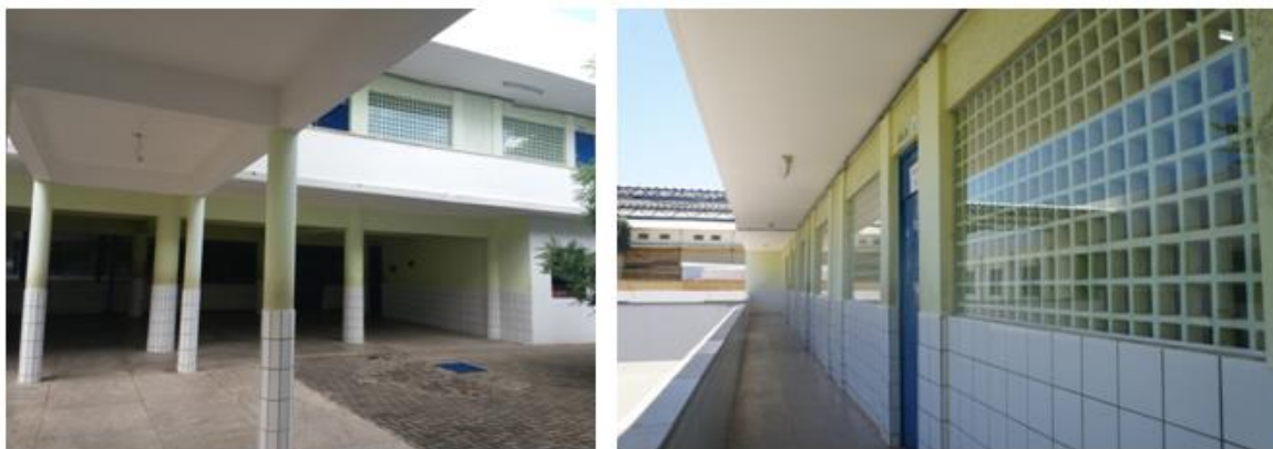
Figura 65: CIRCULAÇÃO ENTRE BLOCOS E LAJE EM BALANÇO
