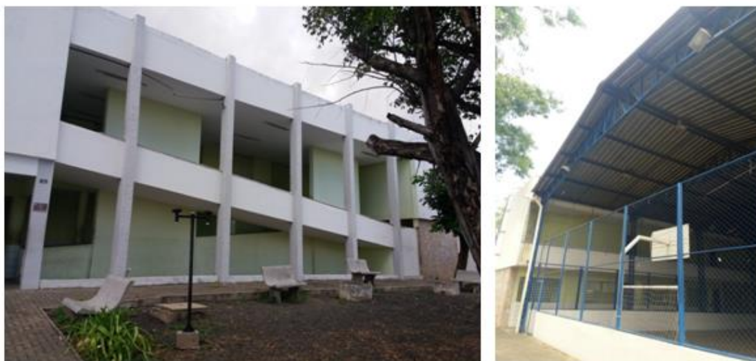
Figura 66: PILARES FRONTAIS E ESTRUTURA DA QUADRA
