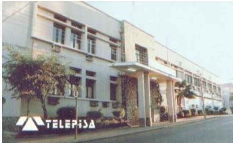
Figura 109: ESCOLA TÉCNICA FEDERAL DO PIAUÍ
