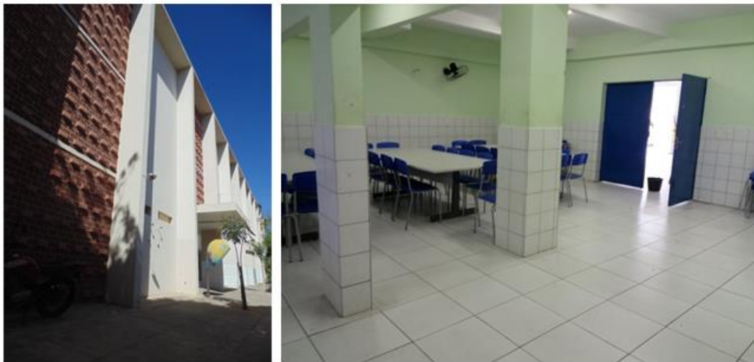
Figura 41: ESTRUTURAS INTERNAS E EXTERNAS
