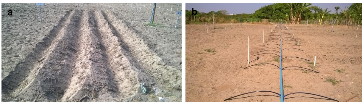
Figura 7 - Abertura dos sulcos para instalação do sistema de irrigação por gotejamento subsuperficial (a). Implantação do sistema de irrigação (b)
