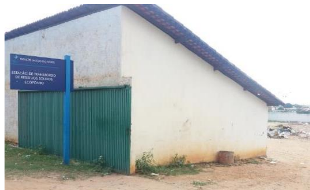
Figura 8.13 – Eco ponto, local para destinação de Resíduos Sólidos
