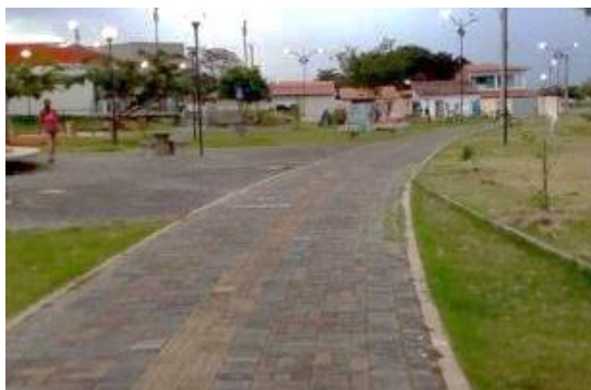
Figura 8.6 – Piso Permeável no Parque Linear
