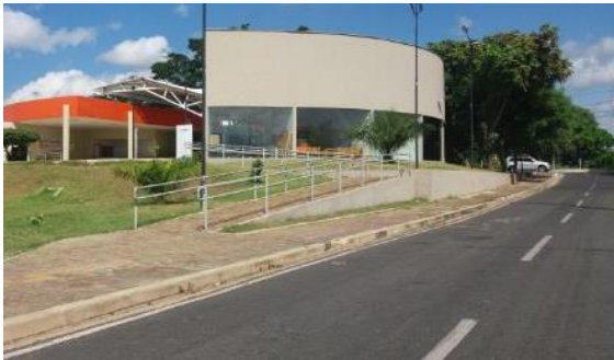
Figura 8.19 – Pavimentação asfáltica na Rua Mineral
