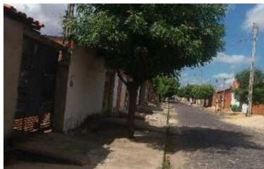
Figura 8.30 – Casas do reassentamento, no Residencial Zilda Arns
