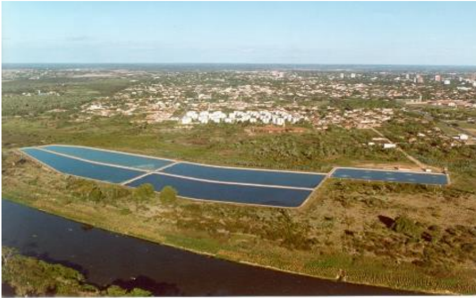
Figura 2 - Estação de Tratamento de Esgoto Leste, Teresina, PI
