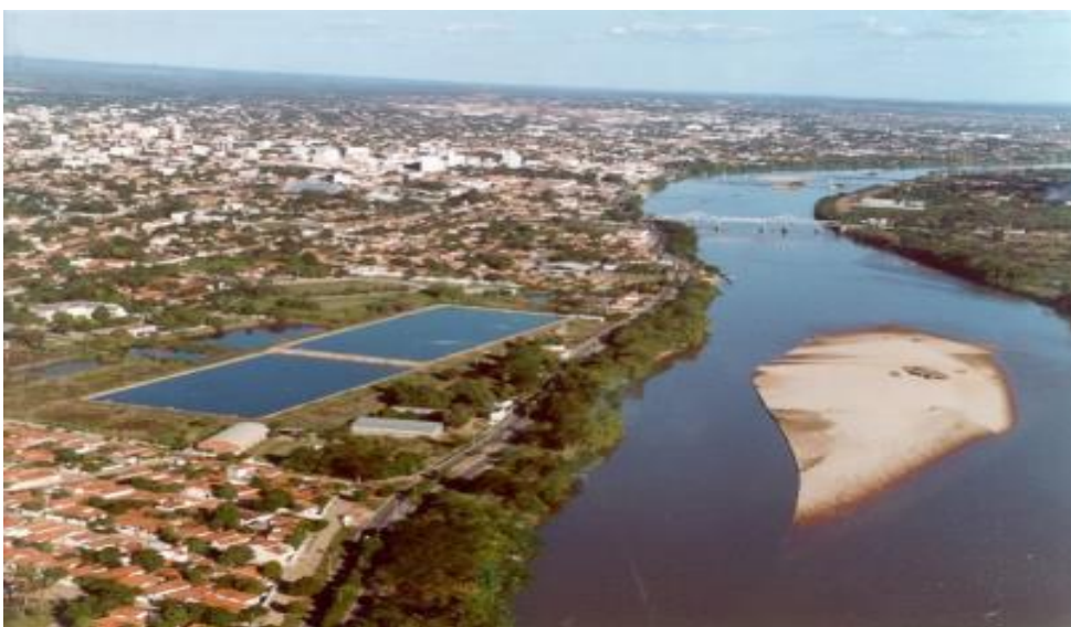
Figura 3 - Estação de Tratamento de Esgoto Pirajá, Teresina, PI
