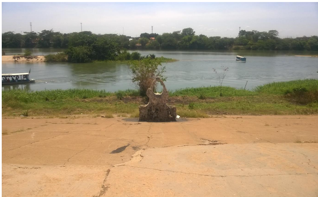
Figura 17 - Ruínas da capela de Iemanjá na Av. Maranhão em frente ao Shopping da Cidade. Novembro de 2015. 273
