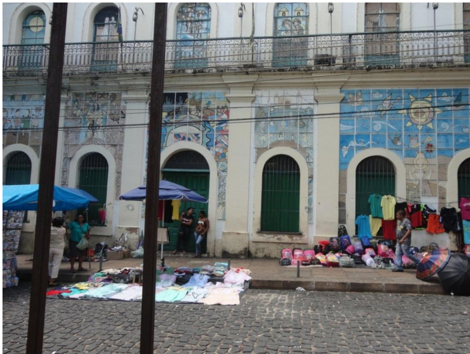
Fotos 14 e 15 – Os ambulantes utilizam as calçadas e as janelas do museu como mostuário de seus produtos. Fonte: arquivo pessoal.
