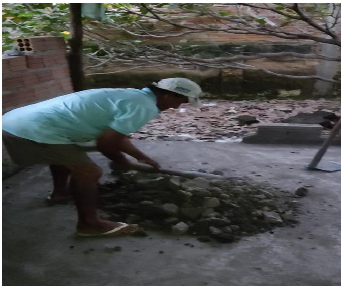
Fotografia 5 - Procedimento de fragmentação das pedras de argila
