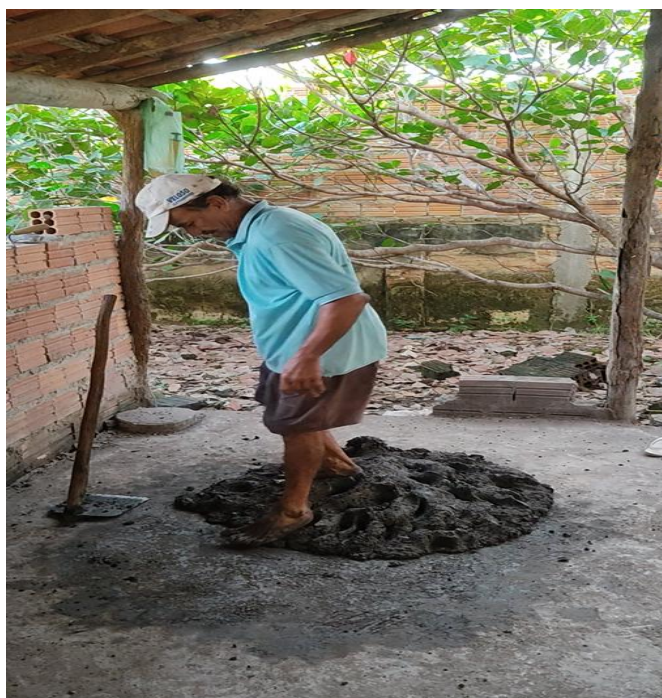
Fotografia 7 - Método do pisoteamento
