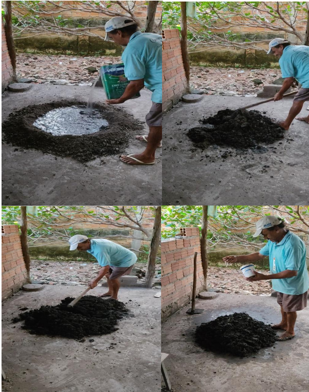
Fotografia 11 - Técnica de corte da massa
