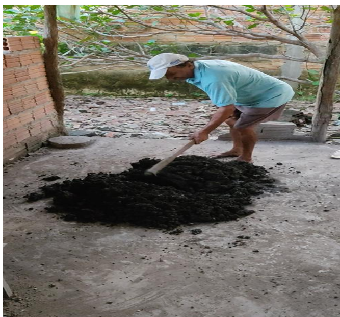
Fotografia 6 - Técnica de corte da massa
