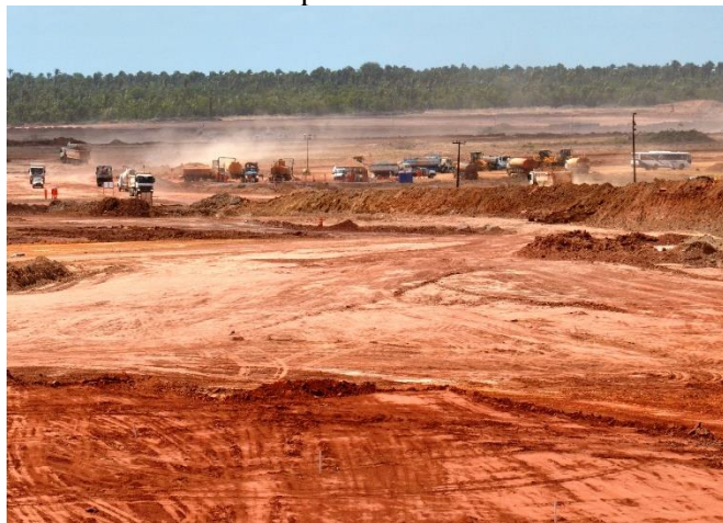
Figura 1-2. Atividades de terraplanagem para implementação de empreendimento petroquímico no Município de Bacabeira
