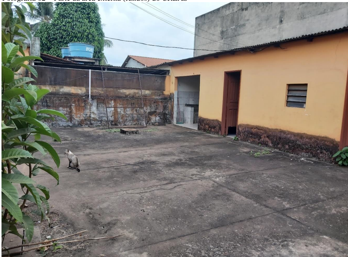
Fotografia 02 – Parte da área externa (fundos) do CREAS
