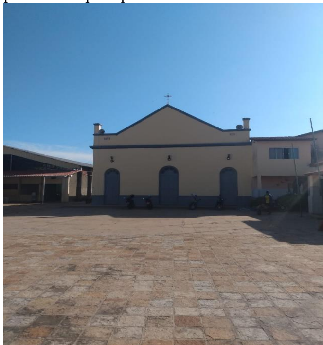
Figura 5 – Igreja de Nossa Senhora de Lourdes e pátio aberto que separa os dois blocos
