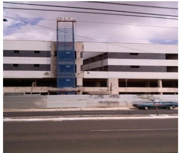
Figura 10 – Obra de ampliação do Hospital São Marcos. Agosto/2014.
