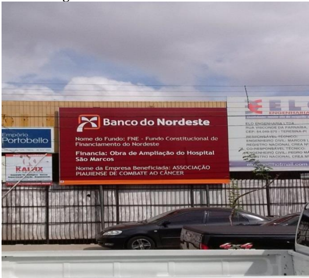
Figura 11 – Reforma e ampliação do Hospital São Marcos. Agosto/2014.
