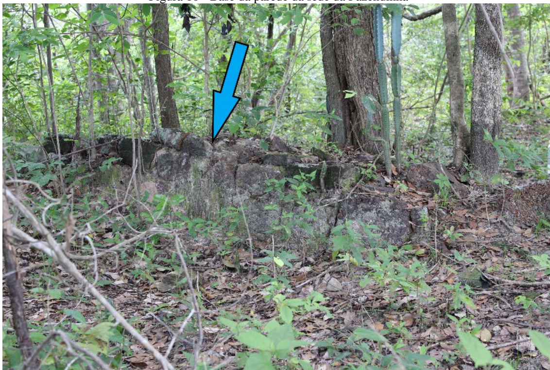
Figura 10 - Base da parede da sede da Fazendinha
