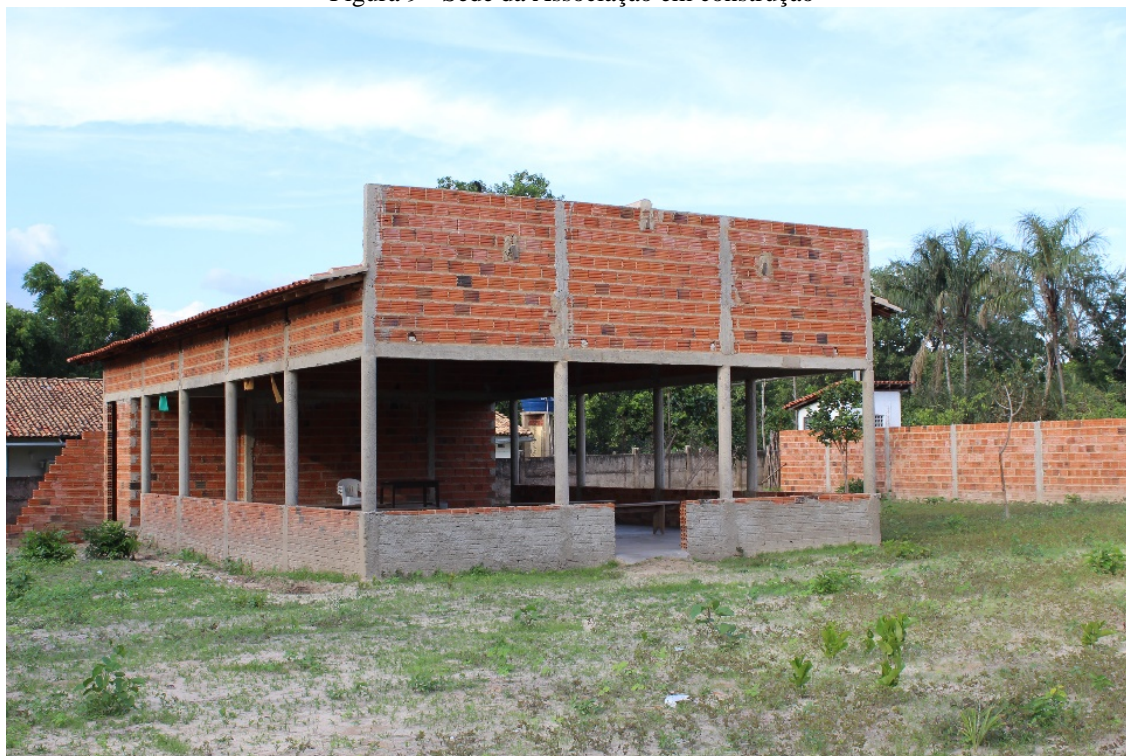
Figura 9 - Sede da Associação em construção
